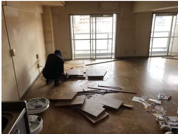
図3 棚解体中写真
