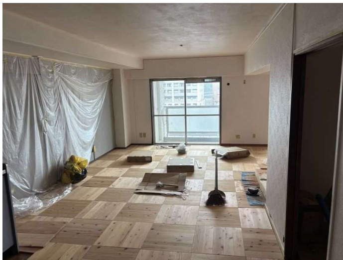
図5 塗装・フローリング完了後リビング
